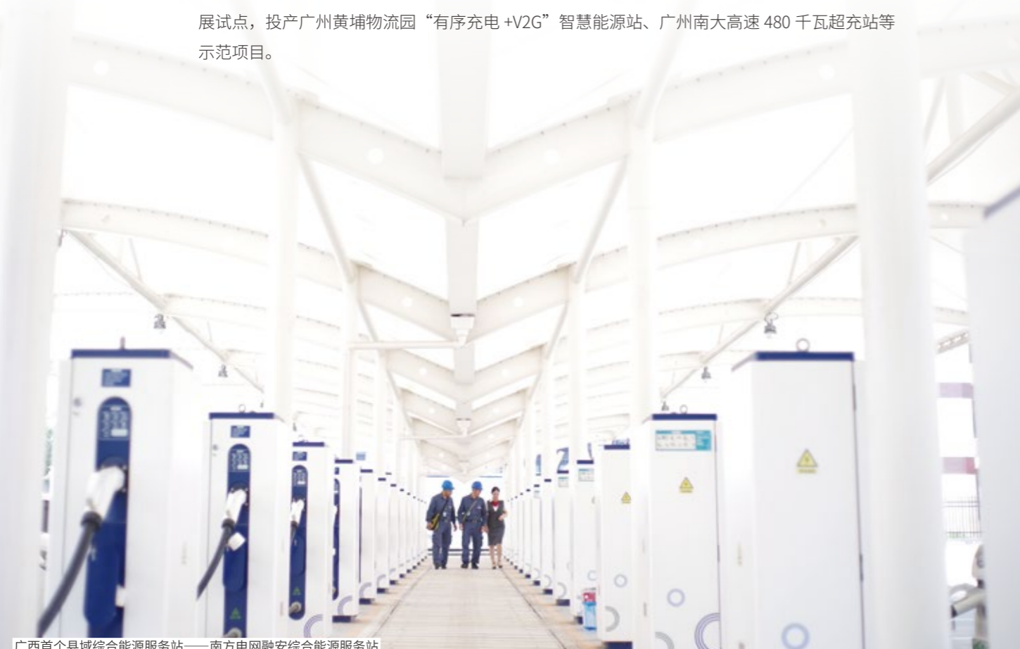
广西首个县域综合能源服务站——南方电网融安综合能源服务站
